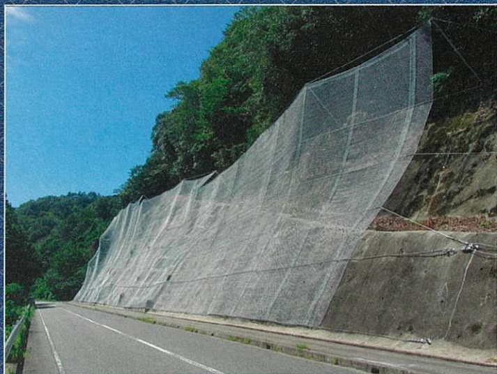
施工事例（ネットタイプ700kJ）
