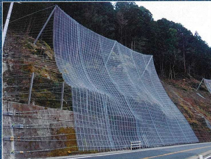
施工事例（ロープタイプ2,700kJ）
