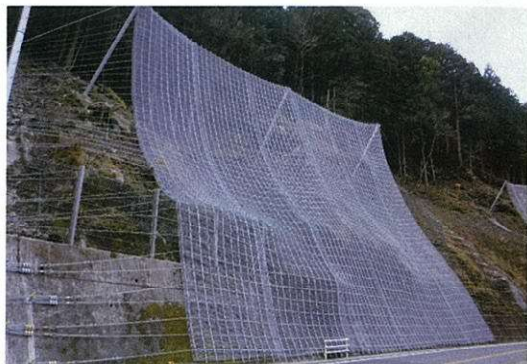
施工事例（ロープタイプ）
