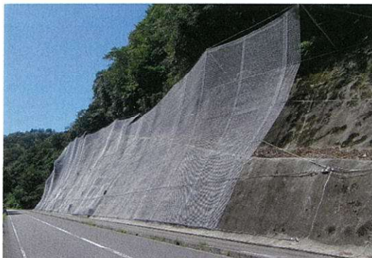
施工事例（ネットタイプ700kJ）
