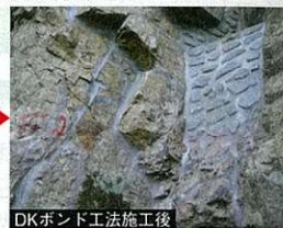
DKボンド工法施工後
