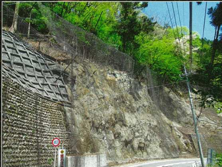
施工事例(ネットタイプ700kJ 景観仕様)
