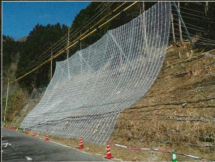
施工事例(ロープタイプ)
