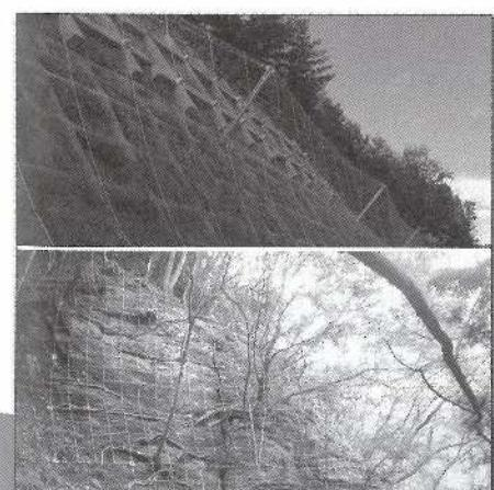
オープンロックネット (ORN工法、写真上) は、ワイヤロープと金網が一体となって落石を受け止め、ネット部全体で落石エネルギーを吸収。より安全で高い強度、施工性を確保した新しい落石防護網工である。支柱に補強材を設け、落石が衝突した場合でも損傷を軽減し、本来の機能を發揮続けることができる。
