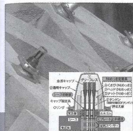
EHDアンカーHP工法 (Epoxy High Durable Anchor HyPer) は、耐久性100年の高付着ECFテンドンを使用し、頭部・白山長・アンカ一体の全体構成を堅固なより高い品質特性にしたことから、安全性・耐久性・ライフサイクル経済性に優れる。アンカー頭部は、透明キャップ・グリースレス定着具・プレート止水構造を用いたことにより、メンテナンス性が向上。さらに定着具は、標準でアンカーフの確実な増減調整機能を具備している。
