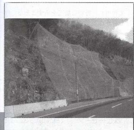
同製品は、高強度な金網およびワイヤロープ、緩衝装置等の組み合せにより、斜面上部で発生した落石を補足した際、落石エネルギーを効率よく吸収しながら、斜面下端まで安全に誘導することを目的とする、高エネルギー吸収型ポケット式落石防護網である。
